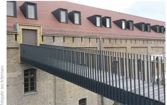
Neubau der Brücke zum Kasernengebäude
