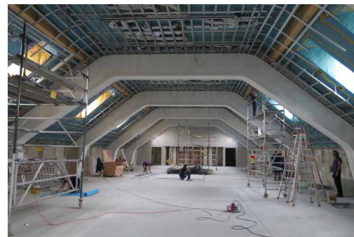
Sanierung des Daches auf dem Kasernengebäudes
