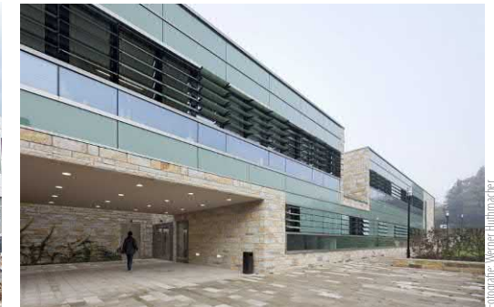
...nach Fertigstellung des Gebäudes
