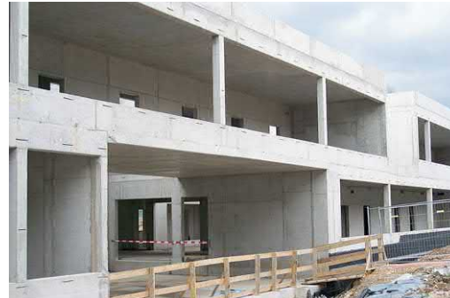
Eingangsbereich im Rohbau...
