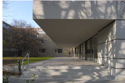
Das auskragende Obergeschoss als Überdachung
