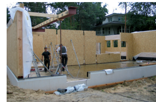
Mensa im Rohbau
