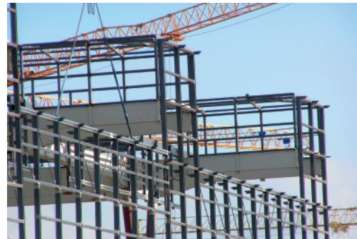
Fassade und Dach im Bau
