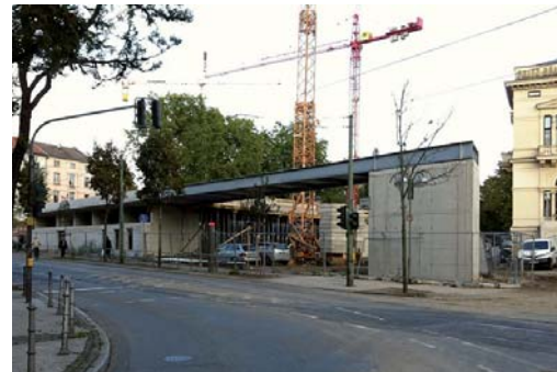
Stahldach über der Toranlage im Rohbau
