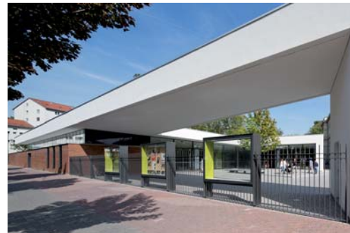
Das Stahldach nach Fertigstellung
