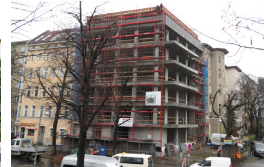
...und nach Fertigstellung des Rohbaus
