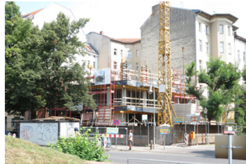
Das Gebäude zu Baubeginn...
