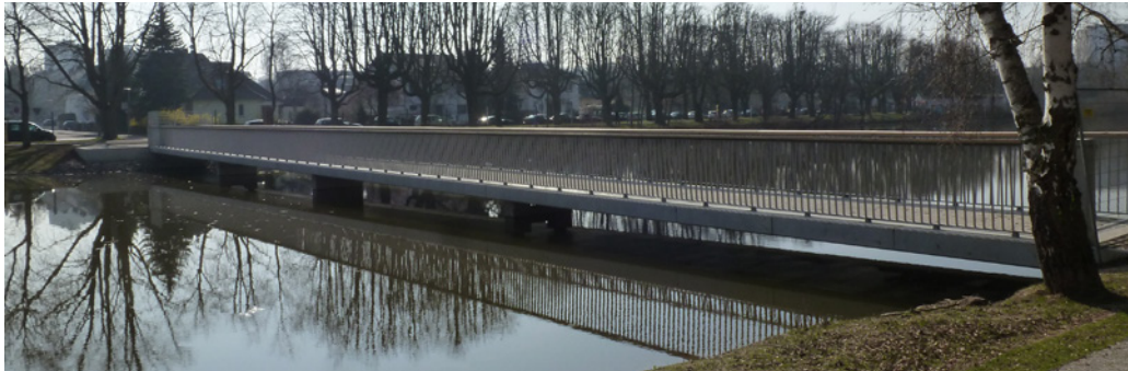
Die Brücke an der Wissenschaftsachse nach Fertigstellung
