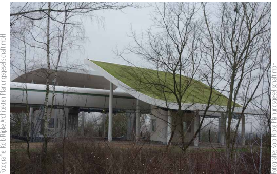
Bauzustand Zwischenstation „Kienberg“
