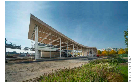
Bauzustand Station Gärten der Welt
