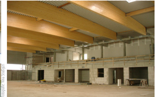
Rohbau mit Brettschichtholzbindern und Tribüne
