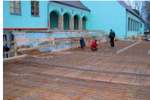
Dach der Nebenräume / Pausenhof im Rohbau
