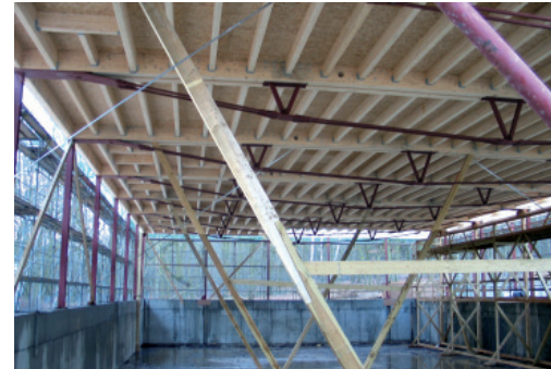
Montage der OSB-Dachkonstruktion
