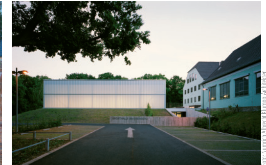
Hallenneubau und Bestandsgebäude
