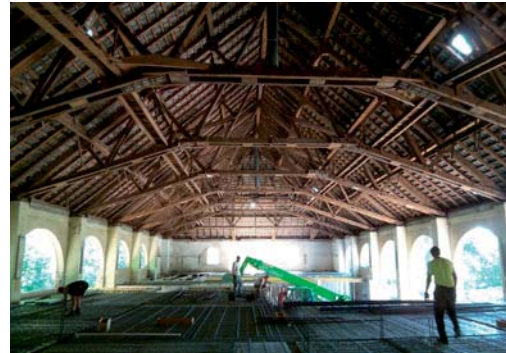
Einbringen der neuen Gebäudeteile
