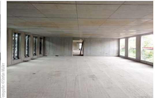
Rohbauzustand des Innenraums
