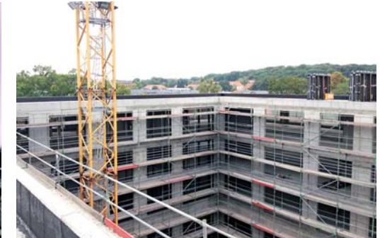
Der Innenhof im Rohbau
