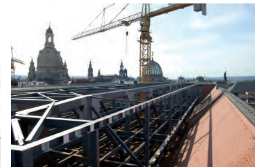
Tragwerk „Brücke“ im Rohbau
